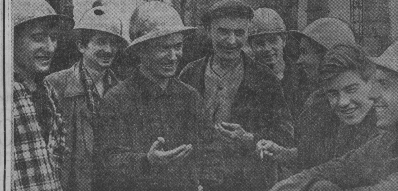
Успешно идет строительство пятого блока Беловской ГРЭС. Строители взяли обязательство сдать его досрочно. Хороших успехов добивается монтажная бригада В. Сарганова (вы ее видите на снимке), которая ведет сборку блоков котла. Фото В. Кафо.
