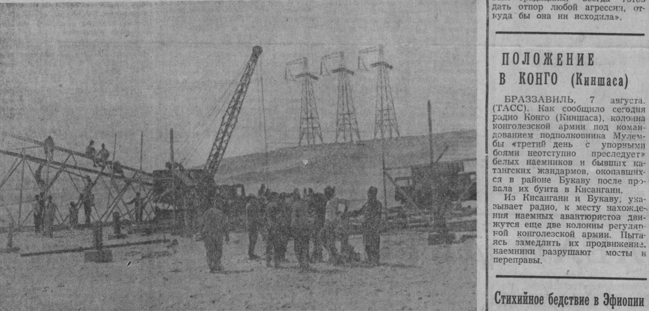
ОБЪЕДИНЕННАЯ АРАБСКАЯ РЕСПУБЛИКА. В конце этого года даст первый ток энергетический гигант Африканского континента — Сауд-аль-Аали в Асване. Советские специалисты помогают строить сооружение более чем тысячекилометровой линии электроснабжения Асуан-Александрия. Высоковольтная линия уже связала Асуанскую гидроэлектростанцию с Каиром. НА СНИМКЕ: завершается монтаж последних опор недалеко от Каира. Фотохроника ТАСС
