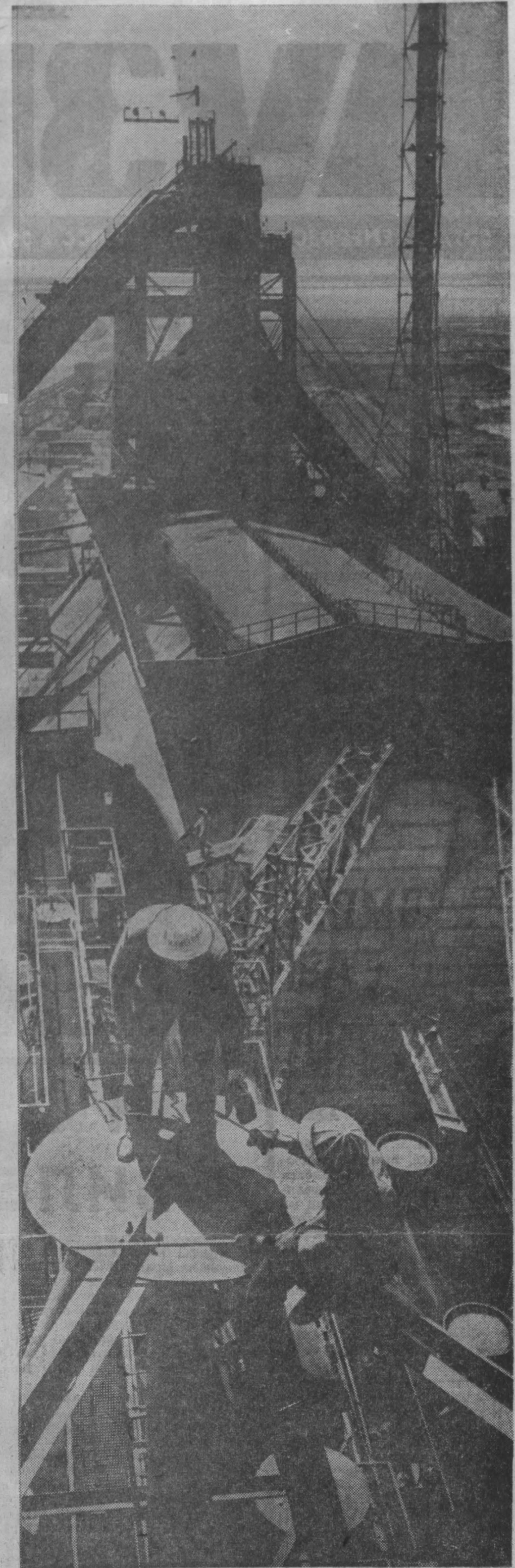
На одном из участков строительства второй доменной печи Запсиба.
