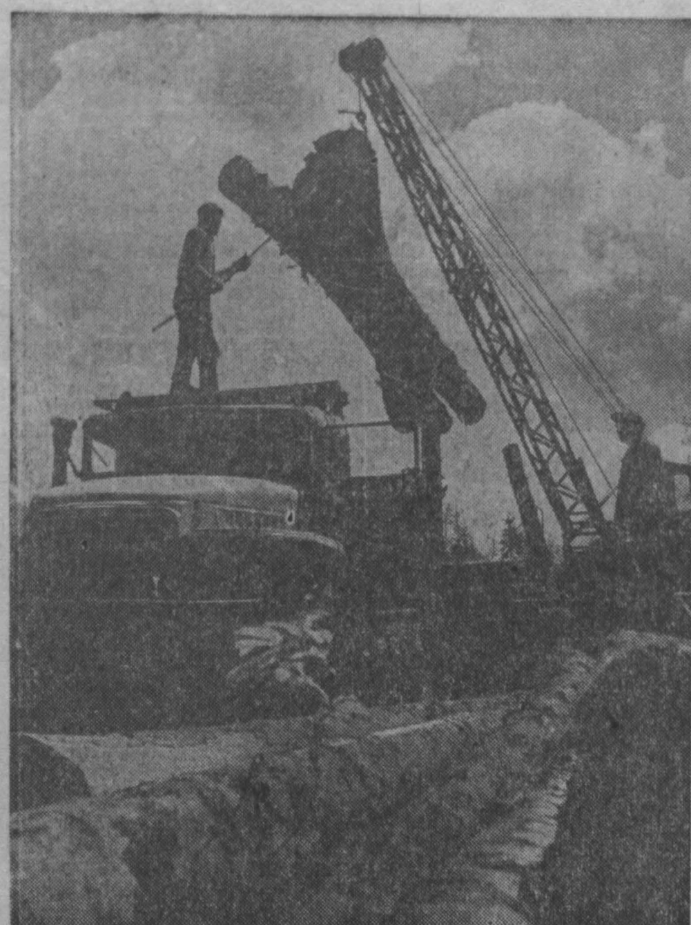
Верхний лесосклад Чумбынского леспромпхоза. Отсюда на стройку в шахты Кузбасса ежедневно вывозится 250—300 кубических метров деловой древесины. Фото Л. Удовиченко.
