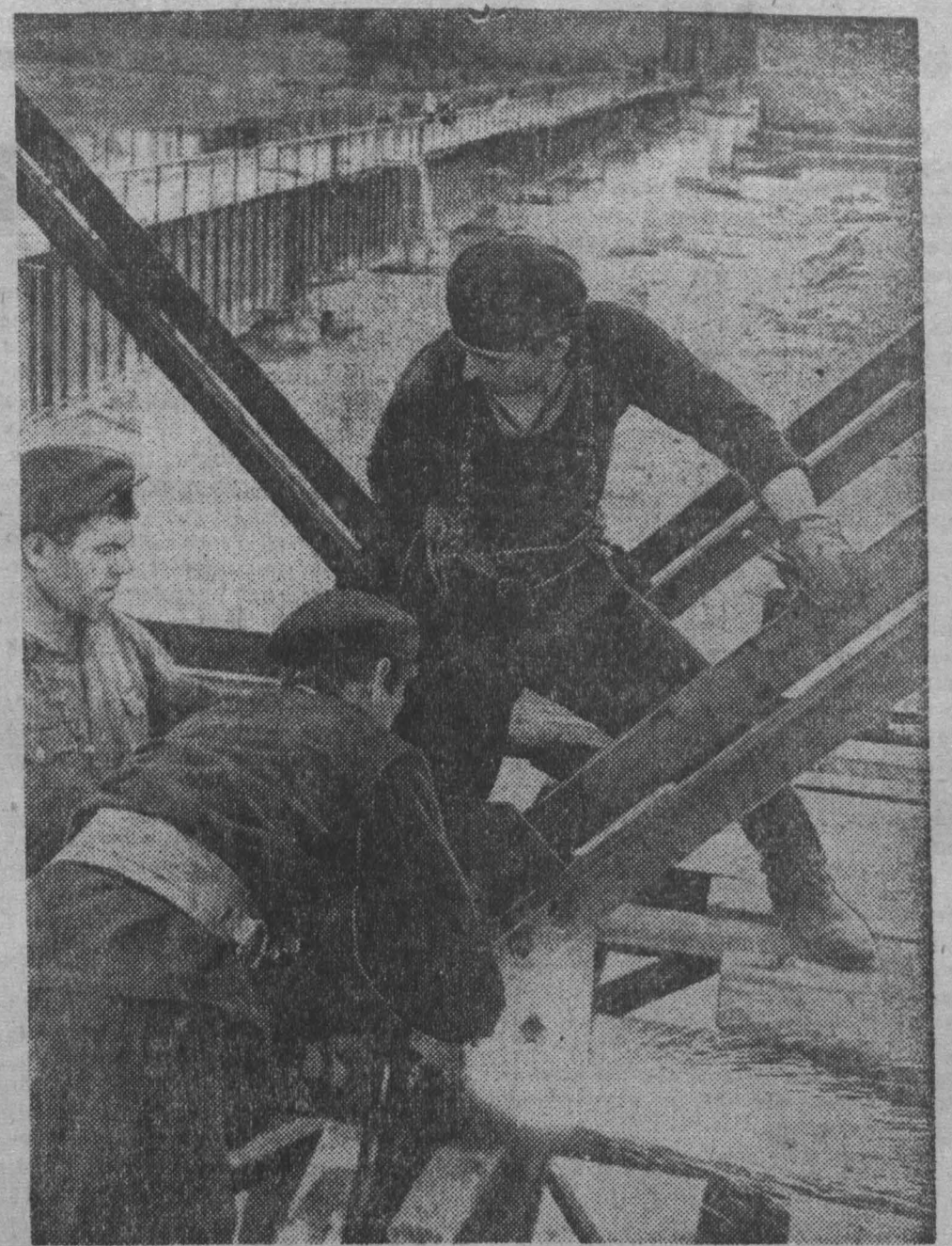
Заканчиваются последние работы на дороге Артышта—Подобас. На снимке вы видите монтажников из бригады В. Самосудова на строительстве моста через Томь на отметке восьмидесятого километра. Фото З. Зитнигора.
