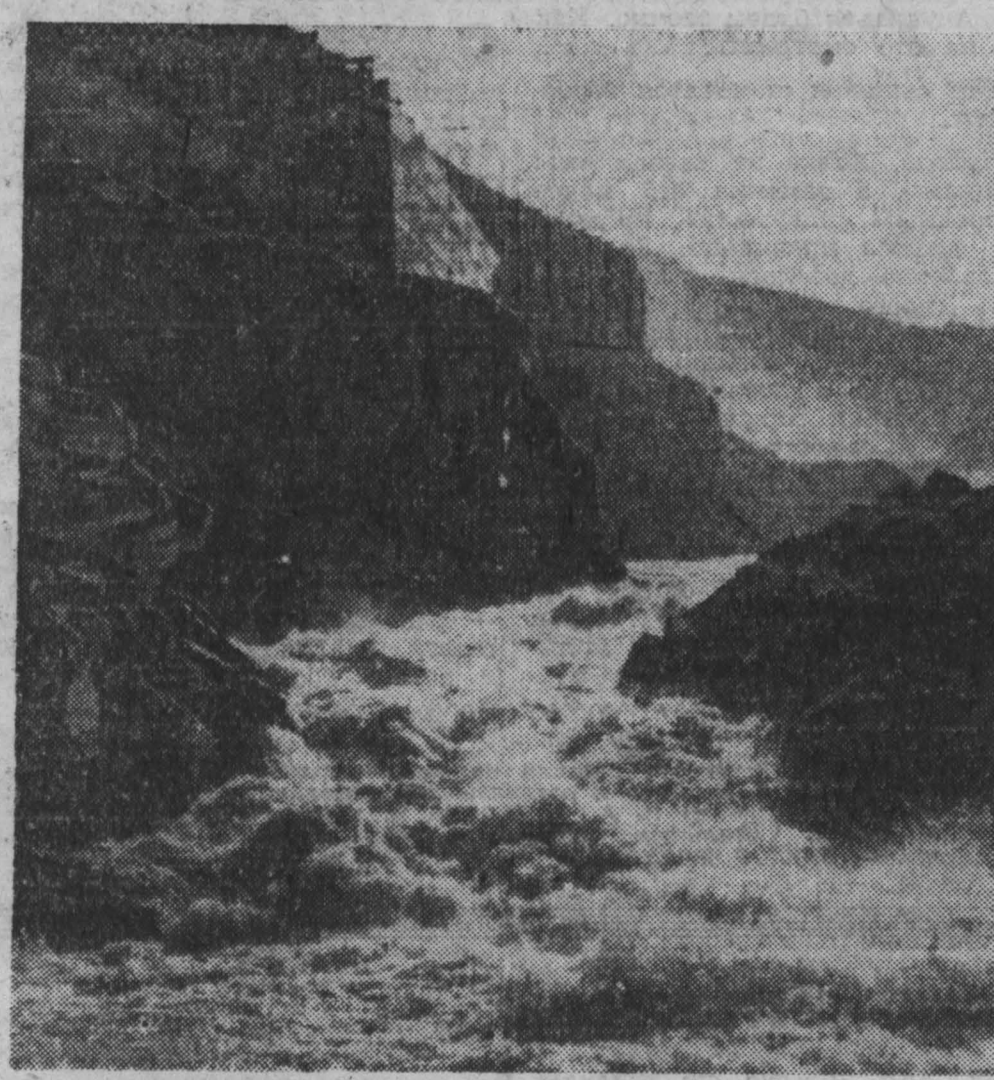
ТАДЖИКСКАЯ ССР. Строители Нурекской ГЭС готовятся к штурму Вахша. На правом берегу реки в месте ее будущего перекрытия, сооружена подпорная 200-метровая стенка, с помощью которой создан необходимый запас булыжника, гравия, песка и глины. С левого берега могучие БЕЛАЯ и КРАЯЯ сыплют в реку скальную породу, сужают русло, чтобы в решающий момент непокорный Вахш было легче перекрыть.
