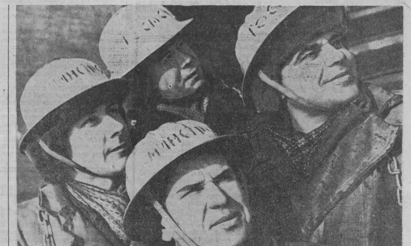
На Топкинском цементном заводе идет окончательная отработка новой технологической линии. Особенно хорошо трудится на предсезонной вахте бригадир монтажников Анатолий Гусев (внизу) вместе с своими товарищами по бригаде Николаем Кричевым, Василием Леонидом и Николаем Егоровым. Фото З. Этингера.
