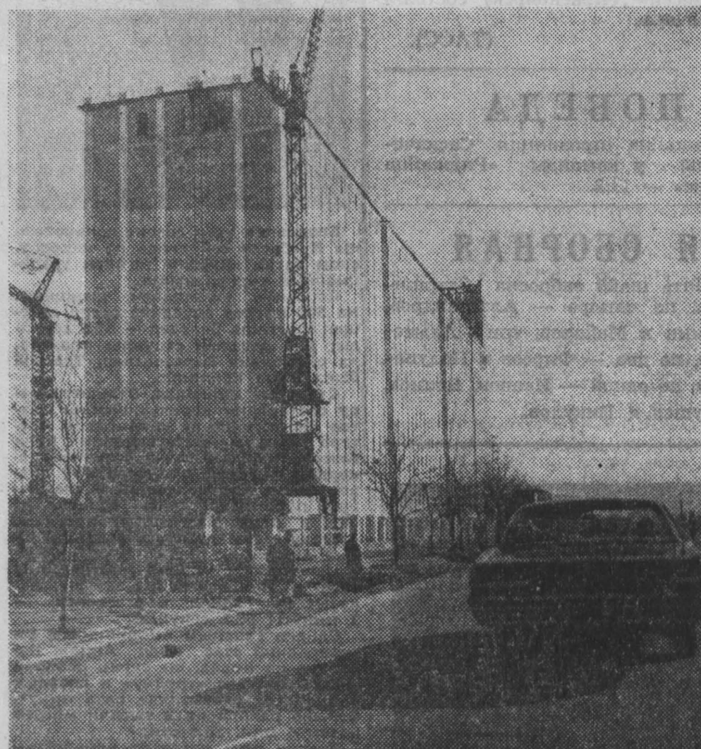
В столице Афганистана Кабуле с помощью советских строителей недавно закончено сооружение второй очереди элеватора. Сейчас начались работы по расширению мельницы и хлебозавода. НА СНИМКЕ: элеватор в Кабуле. Фотохроника ТАСС.
