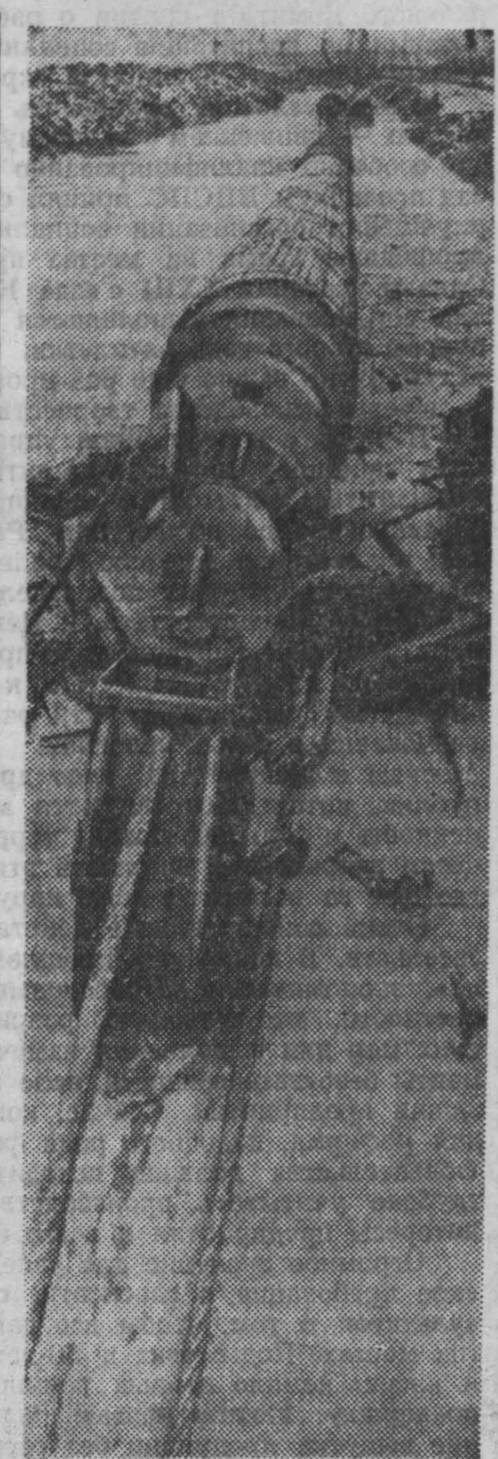
САРАТОВСКАЯ ОБЛАСТЬ. Строители укладывают в дно Волги первую стальную «нитку» транзитного газопровода Средняя Азия — Центр. НА СНИМКЕ: головная часть джонера перед укладкой на дно Волги. Фотохроника ТАСС.
