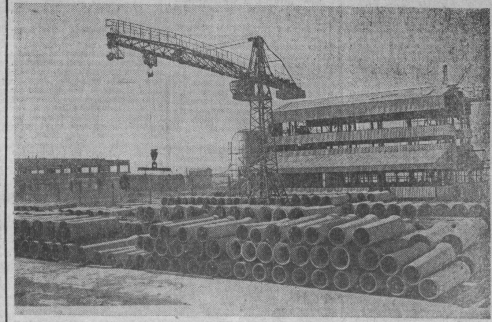
Узбекская ССР. С каждым месяцем увеличивается производство железобетонных труб для водоводов. Коллектив поставил в этом году рекордные показатели по производству труб, выдерживающих напор до 18 атмосфер. НА СНИМКЕ: готовая продукция завода. Фотохроника ТАСС.
