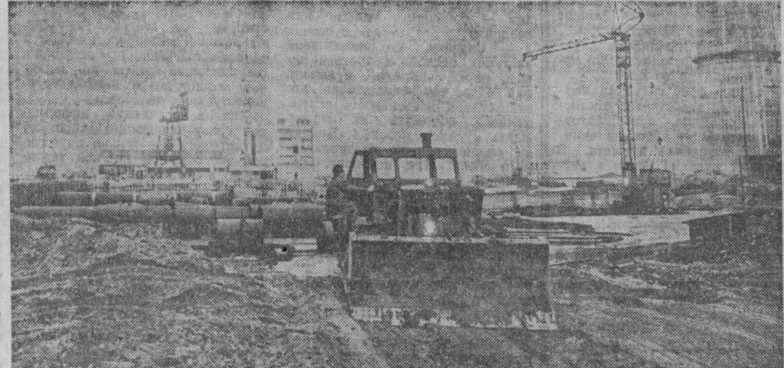
В Северо-Западной Чехии на базе залежей бурого угля создается мощный комплекс теплоэнергетики из семи электростанций на 5.300 тысяч киловатт. НА СНИМКЕ: на строительстве ТЭЦ «Ичерады».
