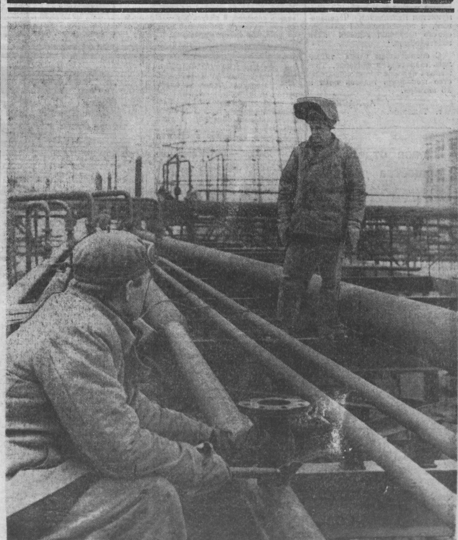
КЕМЕРОВСКИЙ ХИМКОМБИНАТ. Строительство второй очереди комплекса напролантама. Успешно ведет монтаж линии трубопровода бригада Михаила Косоватова. НА СНИМКЕ — на одном из участков монтажа. Фото Г. Андрианова.
