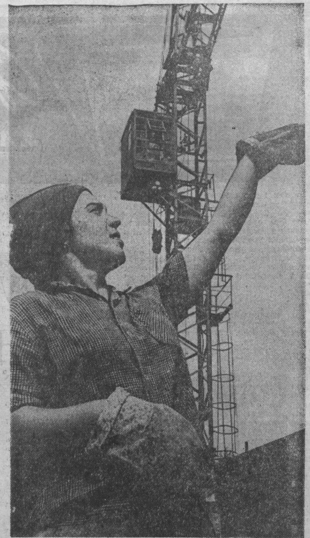
В Анжеро-Судженске строится холодильный. По ударному здесь трудится бригада Д. П. Птагина из второго управления треста «Кемеровшахтострой». Она ежедневно выполняет нормы на 130—150 процентов. Лучшей в бригаде называют строителя Раису Федоровну Верялову. На стройке она трудится пять лет и в совершенстве овладела своей специальностью.
