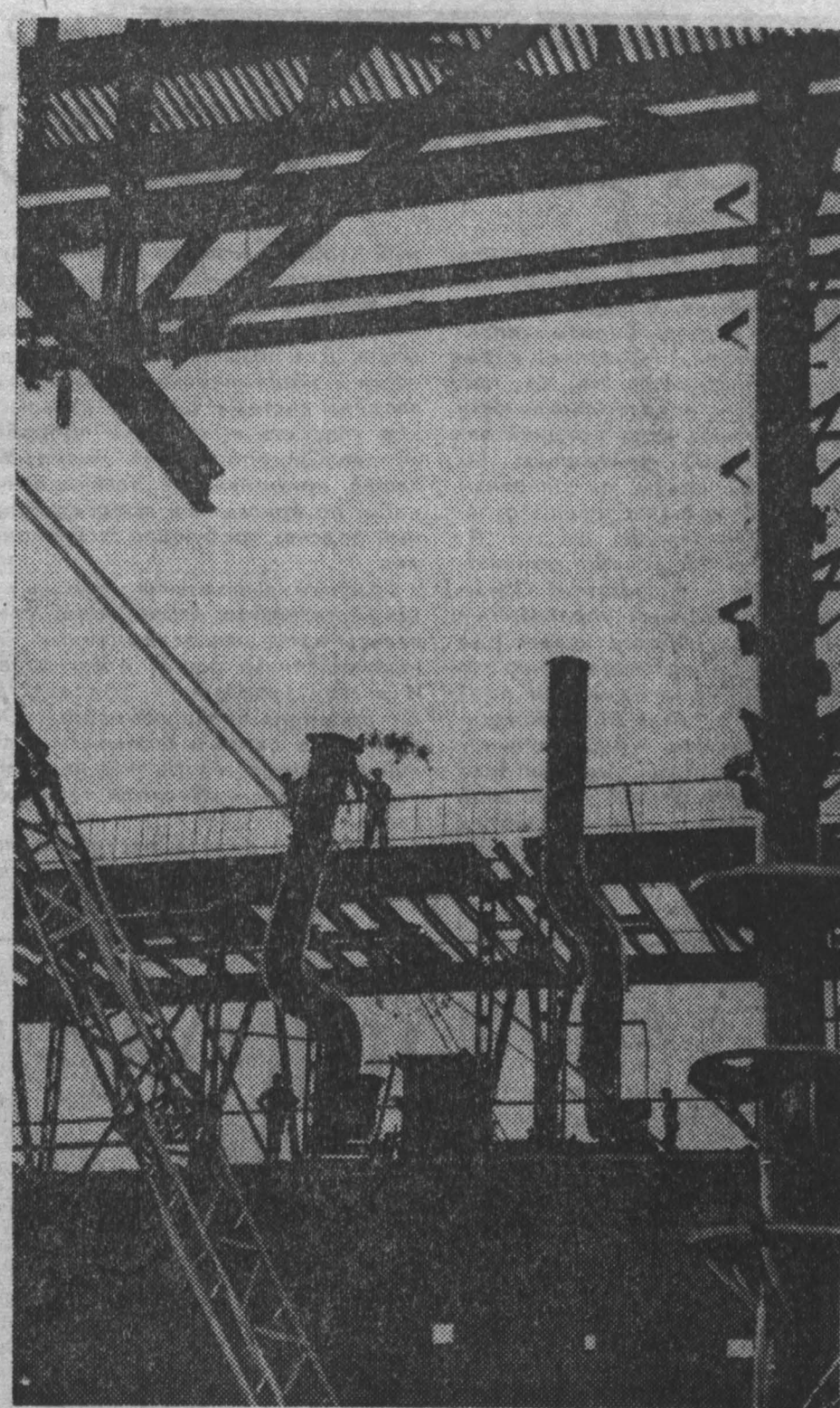
С каждым днем наращиваются темпы строительства второй очереди капролактама на Ново-Кемеровском химкомбинате. На снимках: 1. Монтажники Владимир Марьян (слева) и Алексей Карганов по праву считаются лучшими на строительстве второй очереди капролактама. 2. Монтаж 956-го корпуса. Фото Э. Эттинера.
