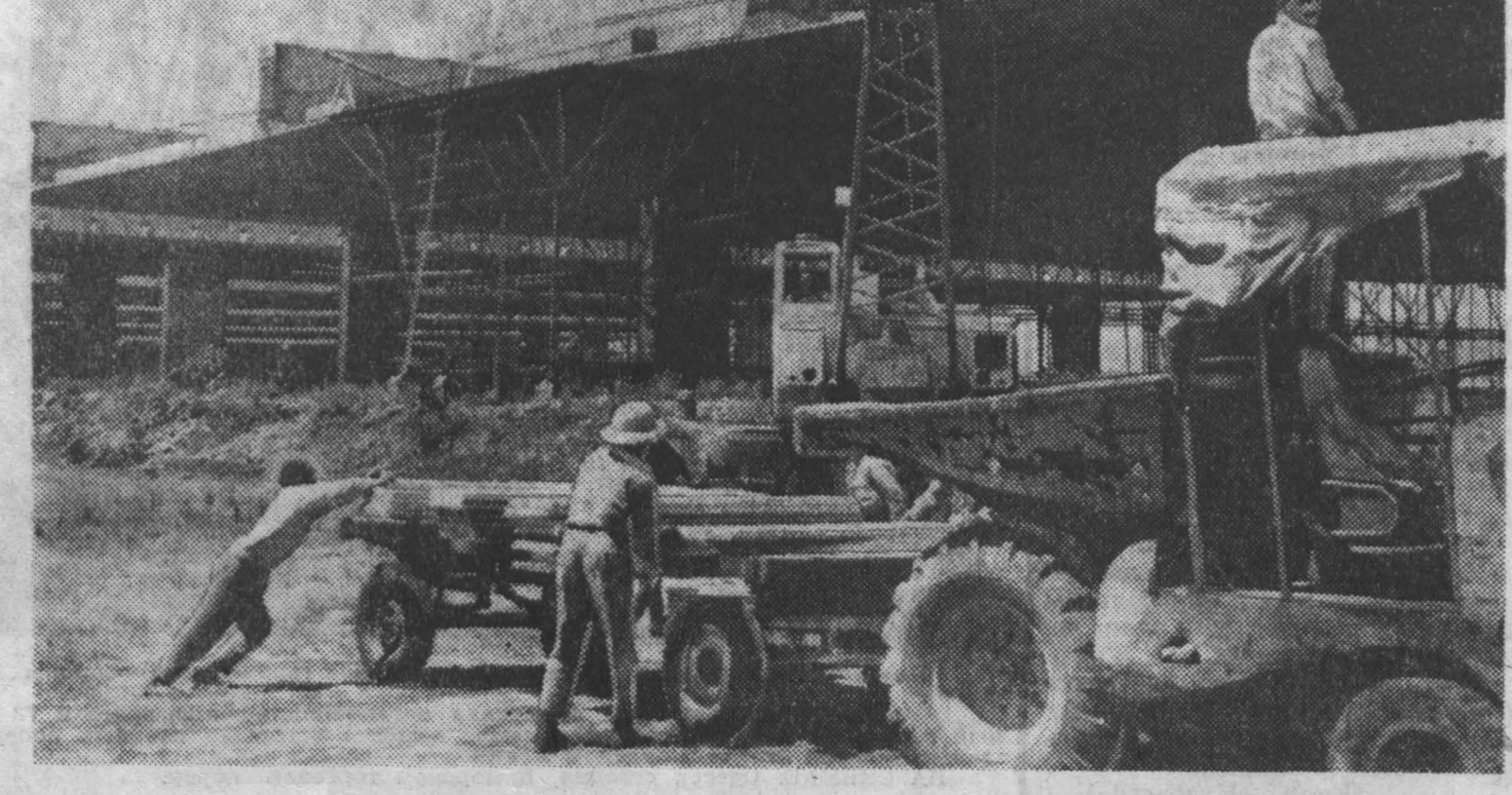
В ливанском портовом городе Триполи идет строительство международного ярмарки, которую предполагается открыть в 1968 году.
