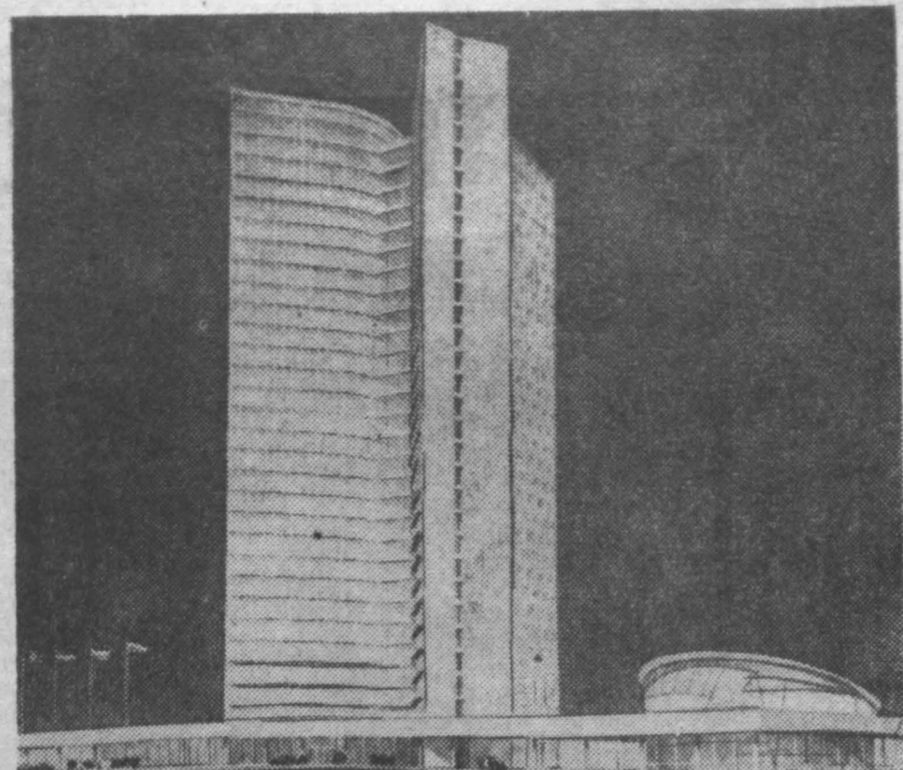
МОСКВА. На проспекте Калинина продолжается строительство ансамбля зданий Совета Экономической Замощности. Здесь будут построены 30-этажное здание секретариата, гостиница, конференц-зал. В сооружении комплекса принимают участие все страны, входящие в СЭВ.
