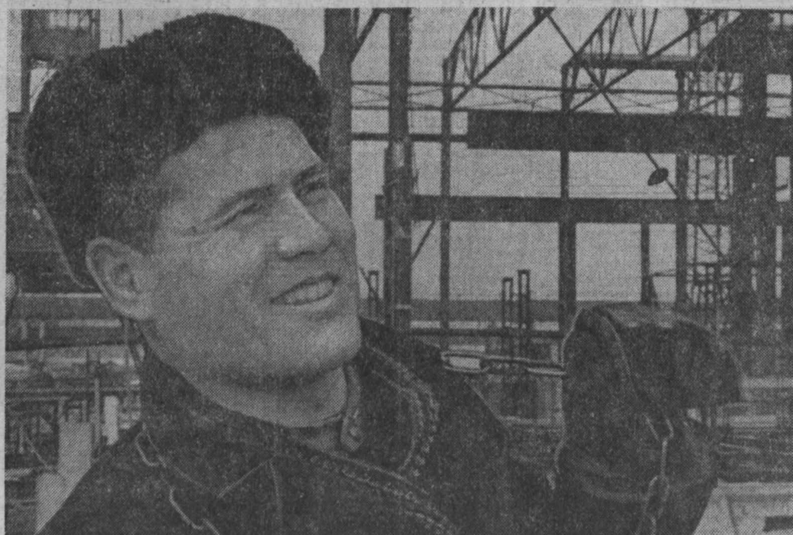
За членами монтажно-вертолетной Анатолия Нелюбина — строительства Череповецкой и Западно-Сибирской комсомольских домов. Теперь Анатолий вместе со своими товарищами по бригаде (ее возглавляет А. Липустик) работает на монтаже прокатного стана «25». Одновременно Анатолий Нелюбин заканчивает десятый класс вечерней школы рабочей молодежи. НА СНИМКЕ: А. НЕЛЮБИН.
