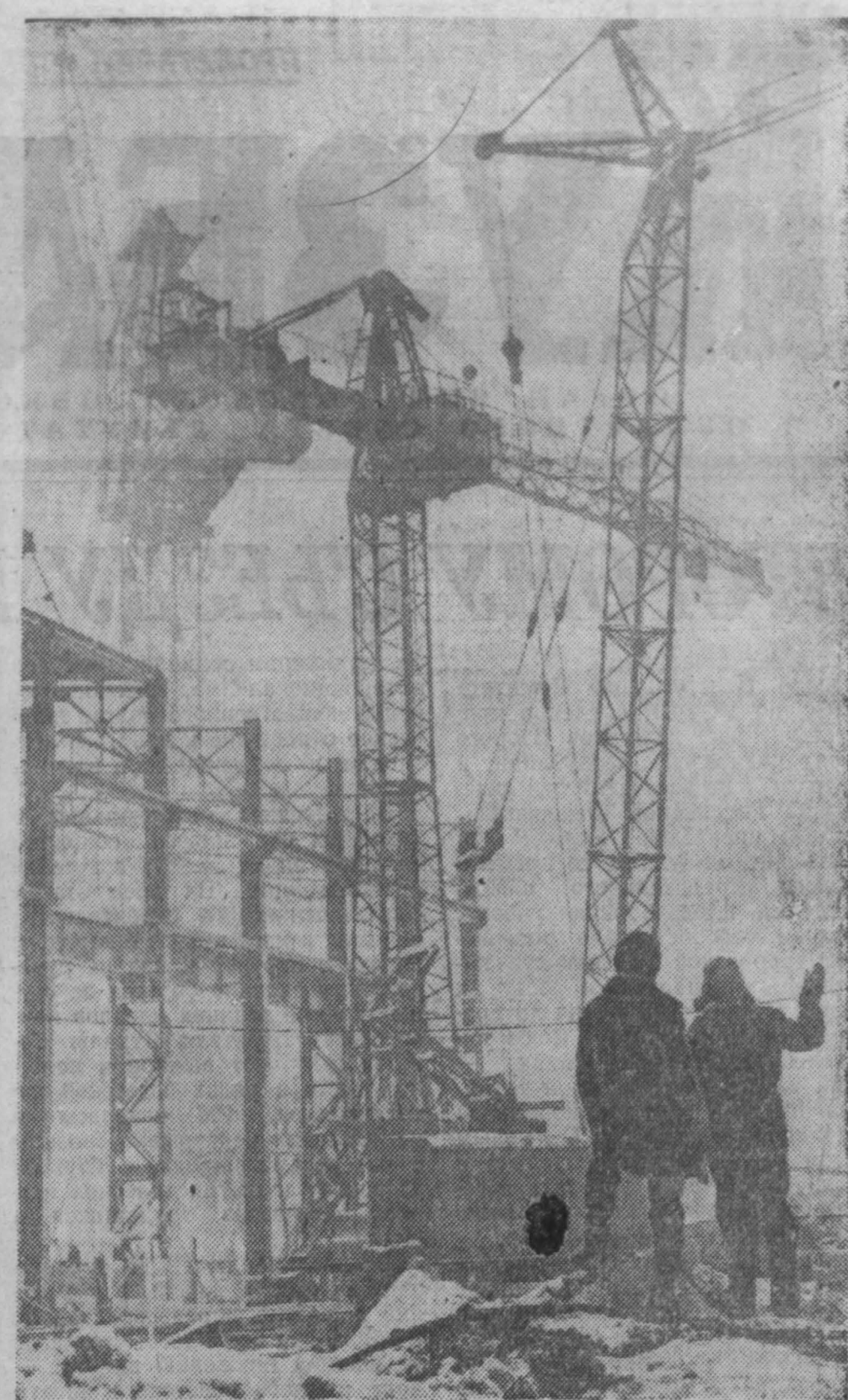
ЗАПСИБ. На головокружильной высоте монтажники устанавливали фермы, раскосы, укладывали панели. Там, где будет массивная обрешетка, в огромную котловину потоком идут машины, груженные «большим бетоном».
