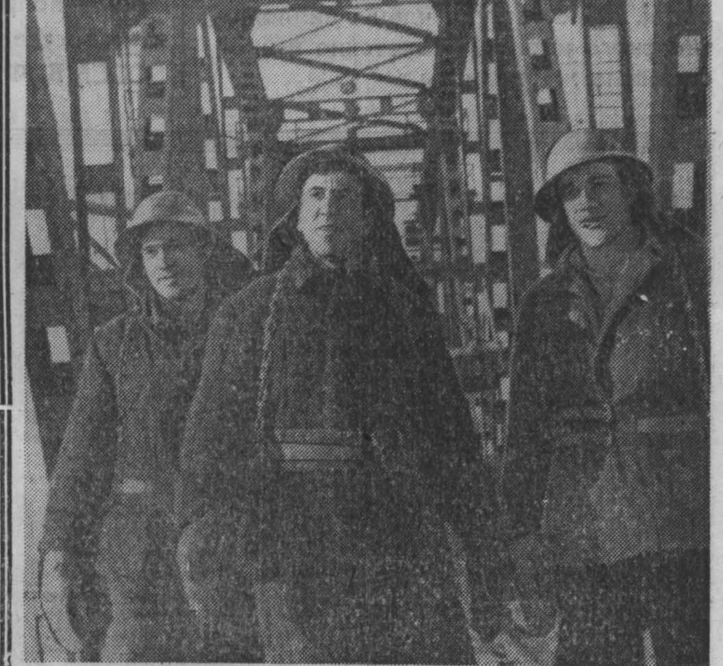
Отлично трудятся на строительстве моста через Томь, который входит в комплекс новой железной дороги Айышта — Подобас, монтажники Б. Курносков, П. Юрченко и Л. Костин. Ребята ежедневно выкладывают по полтора-два задания.
