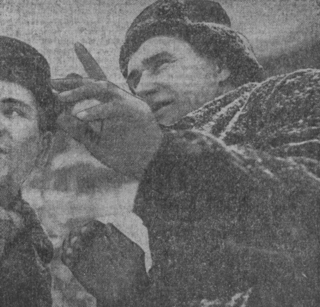
На строительстве вальцеточной мастерской для мелкосортного прокатного стана «250» Западно-Сибирского металлургического завода по-ударному работают кровельщики седьмого управления треста «Кузнецкметаллургострой» Михаил Петрович Федяев и такелажник этого управления молодой строитель Владимир Абдеев. Они рационально используют каждую минуту рабочего времени, бережно и аккуратно расходуют строительные материалы.
