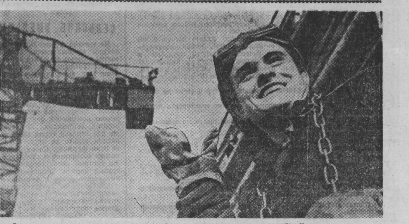
Громоздкие сооружения из стали и железобетона взмывают высоко в небо. Монтажные бригады работают на высоте. Монтажник из треста «Стиральная» Михаил Назаров строит лестницу. Хорошо видно, чем и как он заслужил в коллективе почет и уважение. Фото В. Дунаева.
