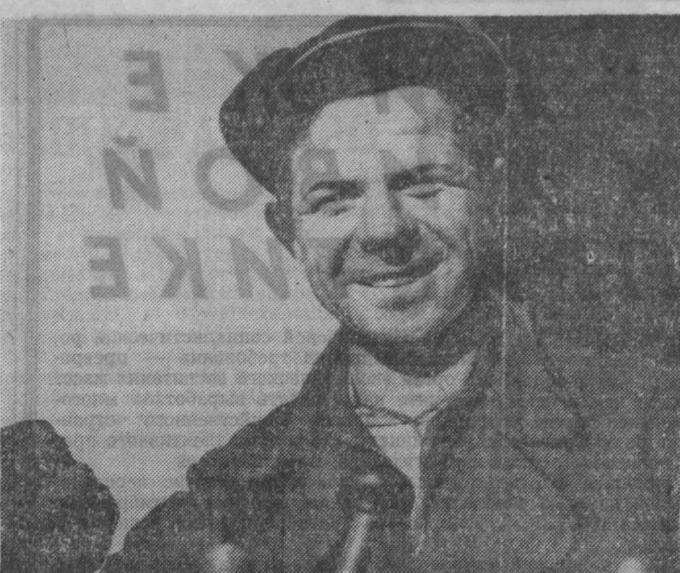
На окраине Белова началось сооружение фабрики белового трикотажа. Сейчас здесь закладывают фундаменты. Коллективная бригада Андрея Максимовича Гордеева ведет заливку подкрановых путей главного корпуса (снимок энтузиаста).
