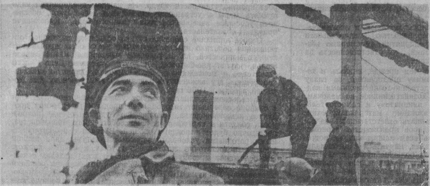
С большим подъемом на строительстве второй доменной печи Запсиба трудится электросварщик 11-го строуправления треста «Кузнецкирмстрой» Николай Башмаров. Свои трудовые подарики он готовит предстоящему празднику Великого Октября.
