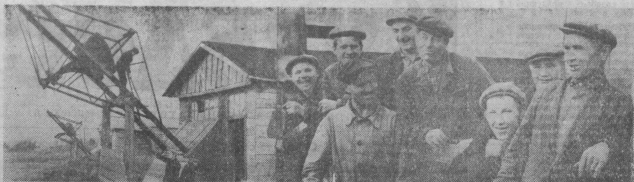
Бригада плотников Афанасия Яковлевича БАГОЙКО из совхоза «Притомский» Новокузнецкого района на ремонте коровника. Фото Г. Черва.
