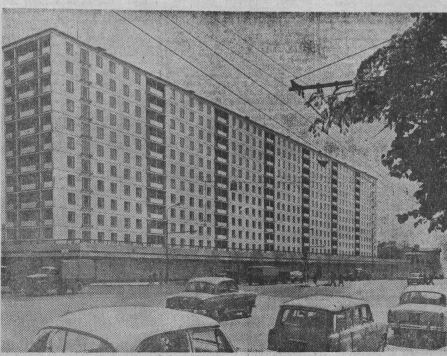
МОСКВА. С оценкой хорошо приняла государственная комиссия новый двенадцатитетяжный дом на улице Чкалова. В здании, построенном из вибропрокатных панелей, 321 квартира. Каждая панель рассчитана сразу на две комнаты. Благодаря этому время монтажа сократилось вдвое. Панели не приваривались одна к другой, а крепились болтами — это точнее и надежнее. Вальс фасада здания протнулись стальные витрины магазинов. Изысканно в доме удобно расправлены, полы устланы новым линолеумом, большие окна пропускают много света и солнца. НА СНИМКЕ: новый дом на улице Чкалова.
