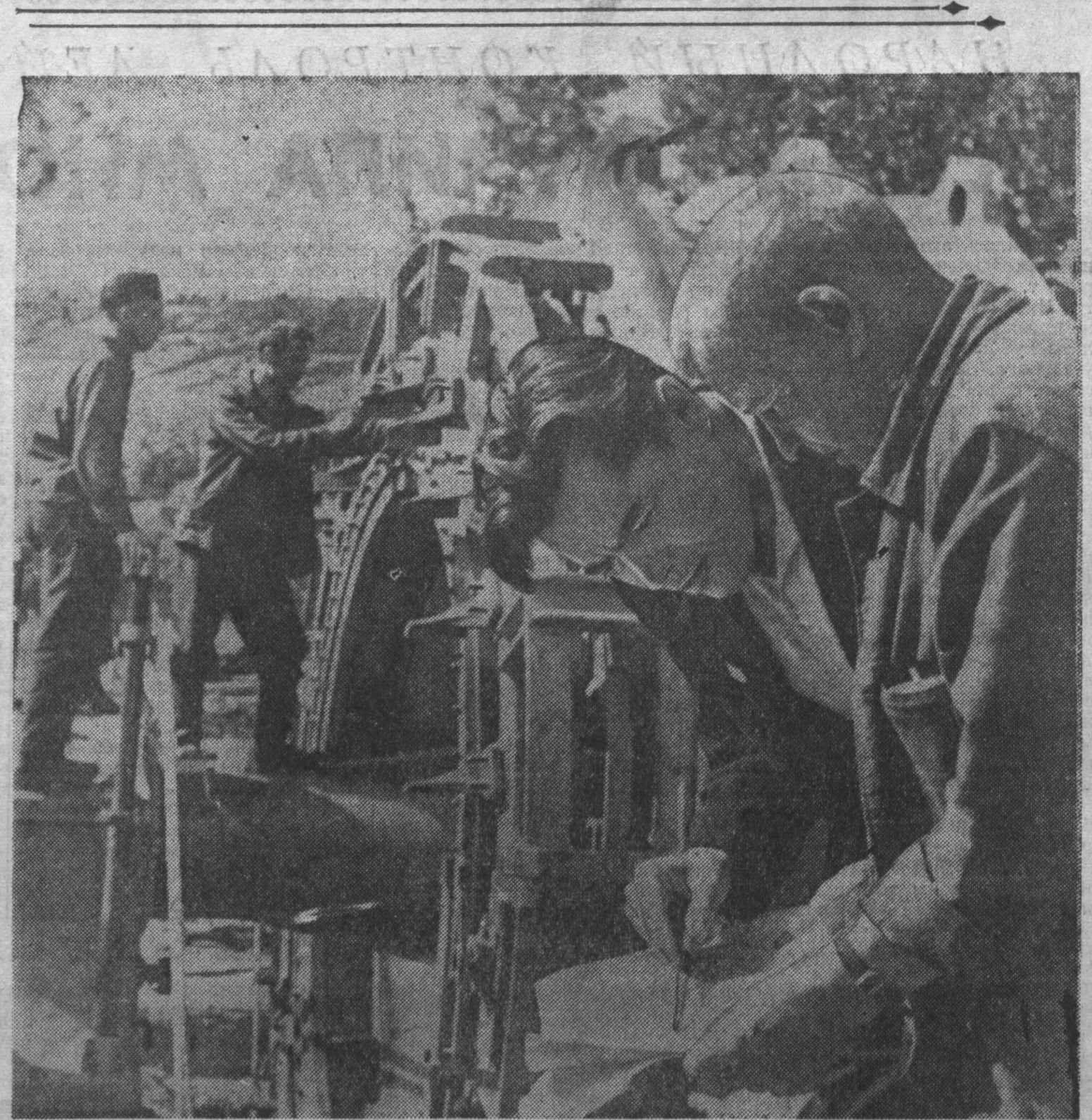
На Таштагольском руднике идет установка новых подъемных машин. Их производительность будет составлять около тридцати тысяч тонн в сутки. Монтаж машин ведет коллектив из Прокопьевского шахтоmontажного управления № 2. НА СНИМКЕ: прораб Г. К. Снегирев и представитель Краматорского завода, откуда пришли новые машины, В. И. Удовиченко за рабочими чертежами. Фото В. Кафо.
