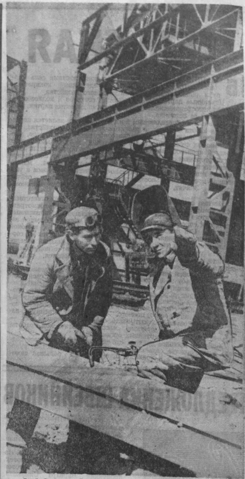
Ямай Сагдиев и Валентин Кальжанов работают на строительстве Западно-Сибирского металлургического завода с 1957 года. Успешно освоили сложнейшие монтажные дела, они ежедневно перевыполняют основные нормы. На снимке: Сагдиев и Кальжанов ведут монтаж воздухопровода на главном корпусе стана «250». Фото В. Воронина.
