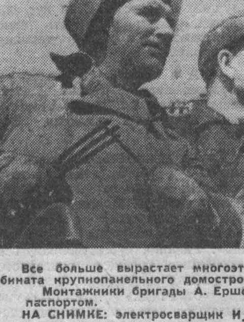
Все больше вырастают многоэтажных домов в девятом квартале заискитимской части областного центра. Их возводят опытные мастера комбината крупнопанельного домостроения — коллективы бригад тов. Ершова, Трофименко, Рязанцева, Репы и Сафронкина.
