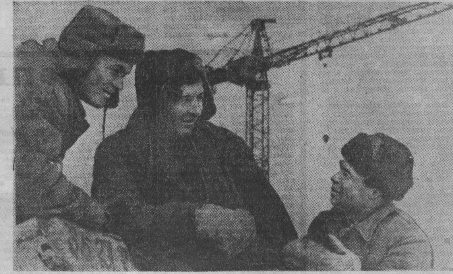
Монтажники бригады коммунистического труда И. С. Близинова из тresta «Кузнецкилстрой» сегодня строят крупноблочный дом в 65-м квартале. Это 75-й дом, который смонтировала бригада за 6 лет. Шесть тысяч человек отстраивали городские кварталы в послевоенные годы. На снимке слева направо: лучшие рабочие бригады В. Суборов, И. Русиков, Я. Мошниниченко. Фото В. Волынина.
