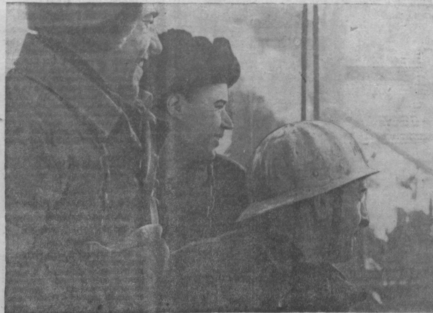
Четвертая доменная печь Кузнецкого комбината в лесак, идет ее ремонт. Строители и монтажники решали сбить доменную печь в эксплуатацию не позднее 28 апреля. Отлично трудится на ремонте агрегатов печи бригада монтажников, возглавляемая Иваном Куренковым из треста «Сибметаллургомонтаж».
