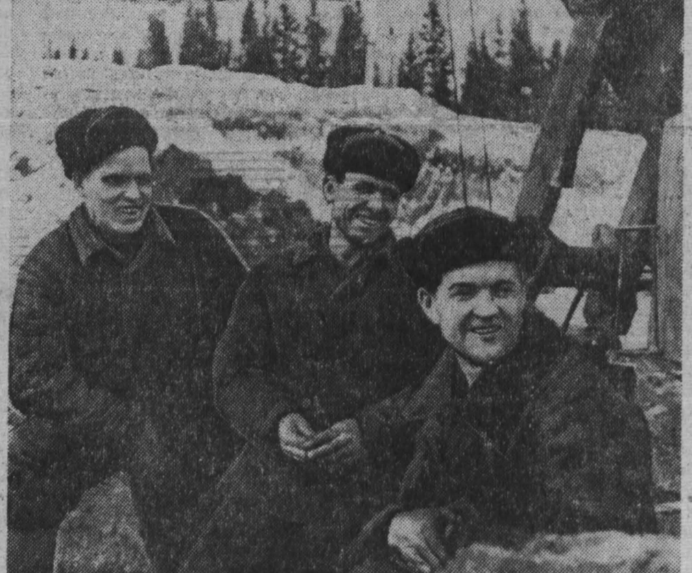
На снимках: строится первая домна Записба (вверху). Разрез Толь-Усинский № 78, еще строится. Но с его богатыми угольными запасами ожидается первый урожай. В марте на одном из открытых участков экипаж экскаватора А. Шеленкова добыл 20 000 тонн угля. Слева направо: машинист А. Шеленков, К. Пономарев, помощник машиниста А. Мамаев. Фото В. Ларина и В. Фоменко.
