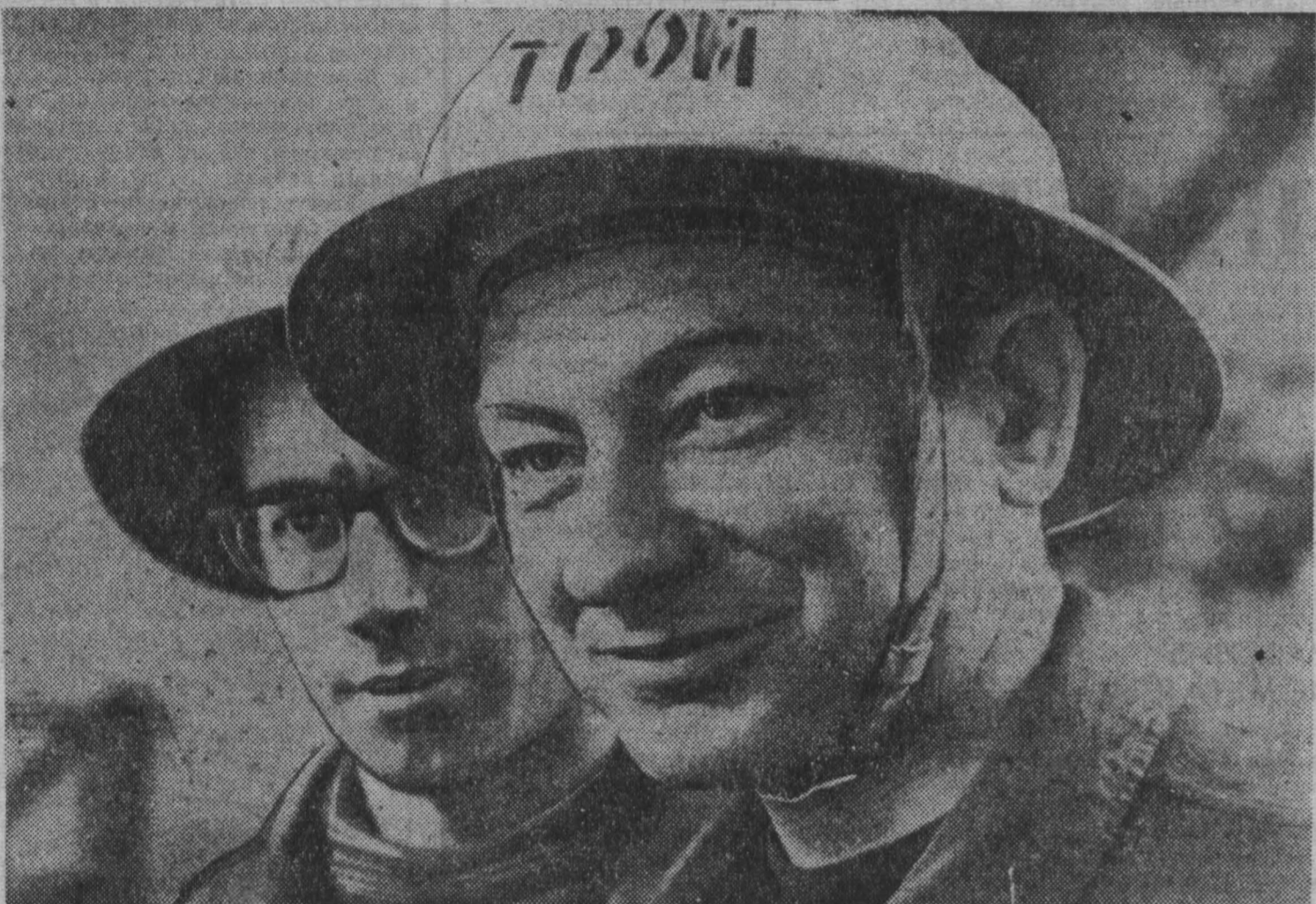
Успешно ведет монтаж оборудования в цехе карбидов Ново-Кемеровского глиноземабригада т. Миронова. Монтажные бригады Андрей Шапкин и Виктор Акишин из этой бригады зарекомендовали себя замечательными специалистами. НА СНИМКЕ: А. Шапкин, В. Акишин. Фото З. Якущенко.
