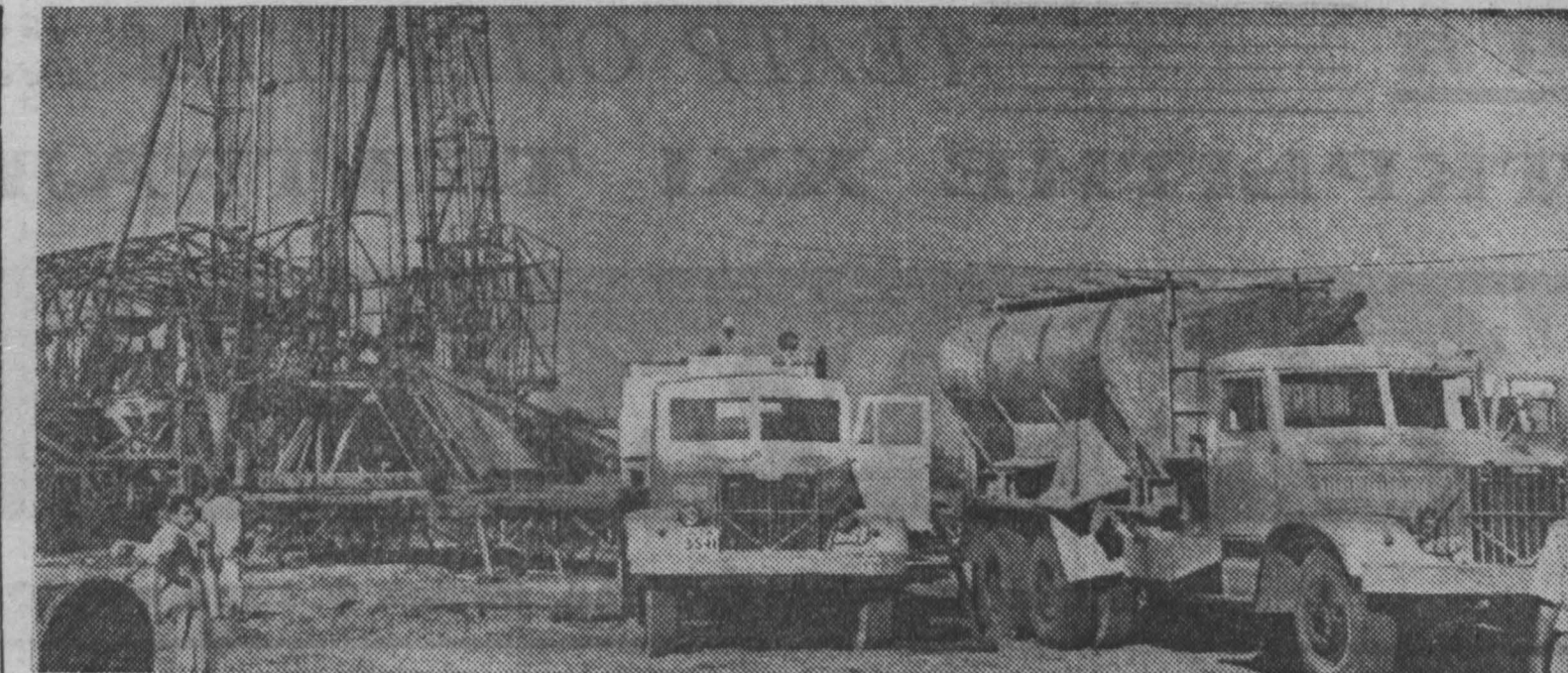
Анкешвар стал крупным государственным действующим нефтеперерабатывающим заводом. Он дает около 2,000 тонн «черного золота» в сутки. Продолжается разработка новых месторождений. НА СНИМКЕ: эксплуатационная скважина. Для цементирования скважины используются специальные советские машины.
