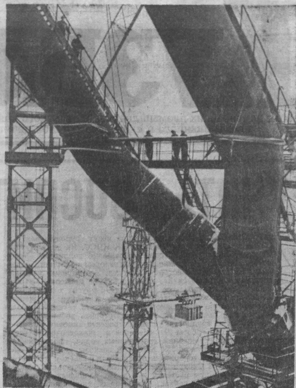
ЗАПИСЬ СЕГОДНЯ. Идет сооружение первой доменной печи. Фото А. Кузарица.
