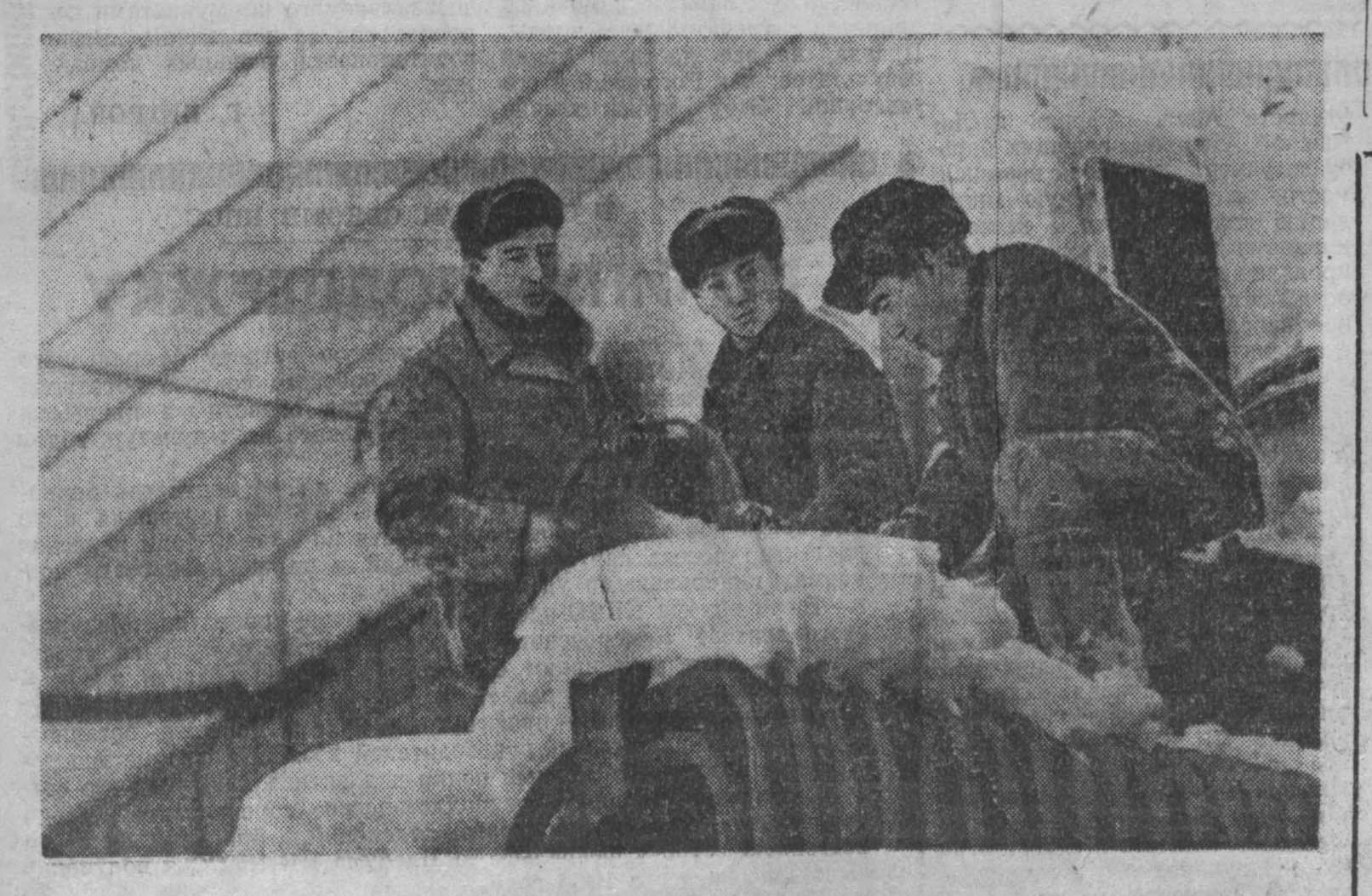
Бригада электросварщиков А. Мишинина из треста «Сибэлектромонтаж» занимается сборкой первого в Сибири экранированного шинпровода голозного трансформатора среднего блока Томь-Усинского ГРЭС.
