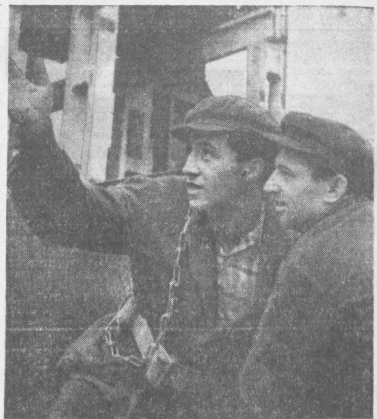
Отлично работает на возведении главного корпуса Абагурского атофабрики бригада монтажников Юрия Керина. НА СНИМКЕ: лучший монтажник Новосибирского строительного-монтажного управления треста «Сибтальстрой» Иван А. ФОНИН (слева) и бригадир Ю. КЕРИН. Фото В. Воронина.
