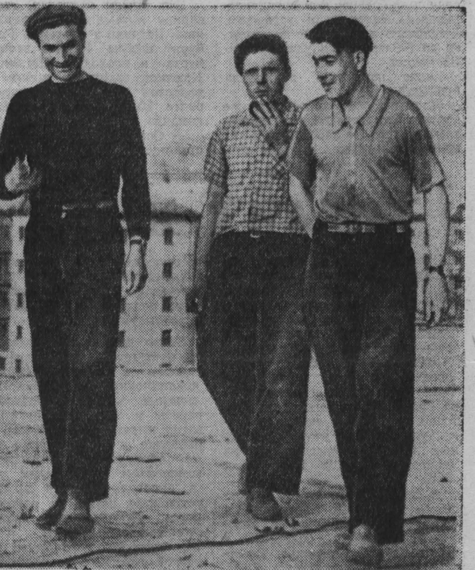
Работа идет по перекрытию пятого этажа нового восьмидесятиквартирного жилого дома в 32-м квартале Междуреченска. Это десятиэтажный дом, который они монтируют в своем городе, а ведь совсем еще недавно они практически монтировали такие дома у строителей Новокузнецка. На строительстве жилья в бытовых учреждениях города Междуреченска активно работает советский коммунистический труд Томского управления треста «Томмашинстрой», руководителем которым Николай Тимофеевич Гусков. А бригады строителей-монтировщиков Владимира Васильевича Попова, в которой трудятся эти парни, высокое знание завоевала одной из первых тресте еще два года назад. На снимке члены бригады В. В. Попова (слева направо): Александр Пахомов, Александр Устюжанин и Федор Халилов. Фото В. Ларина.
