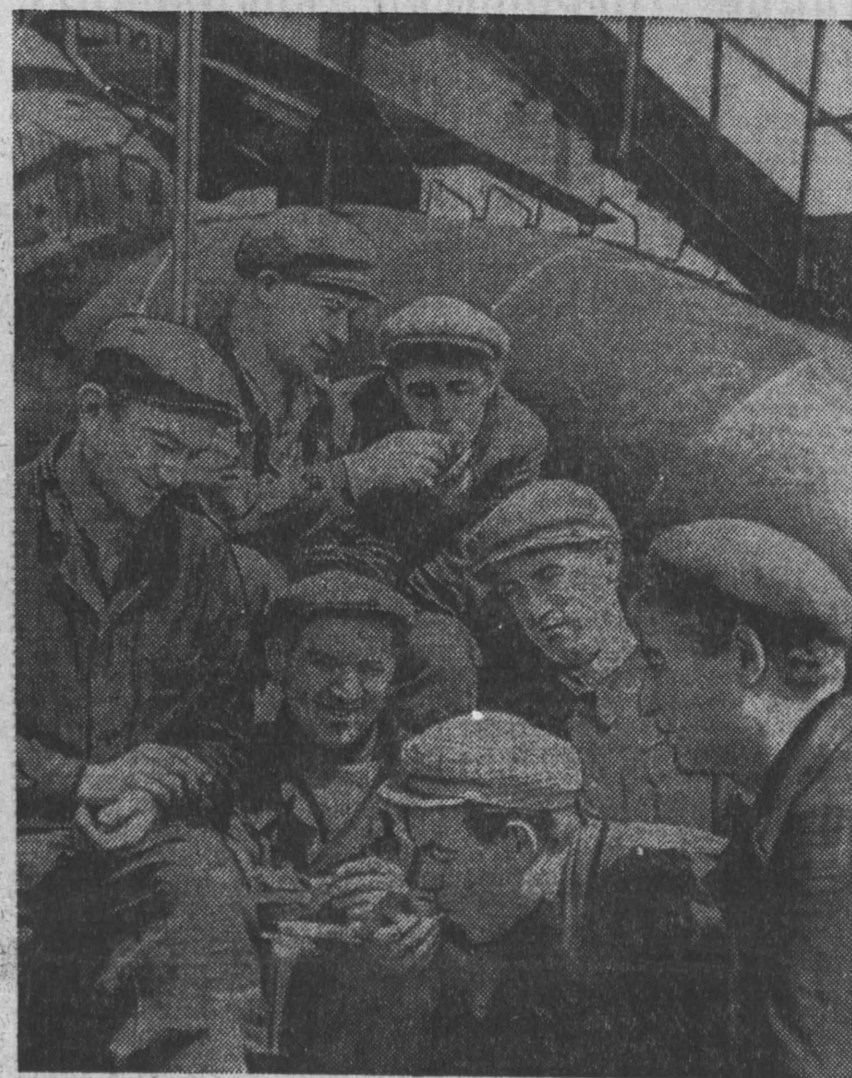
Бригада монтажников из «Сибстальконструкция», которую возглавляет Николай Агарков, на сооружении домы Записба трудится с самого «корня». Недавно им поручили смонтировать наклонный мост. Дружно принялись за дело, в объект был слан на четыре дня раньше срока. На Записбе уже привыкли к рекордам, но такого еще не было. — А теперь можно перекурить, ребята, — шутит бригадир (в центре). Фото В. Сизова.
