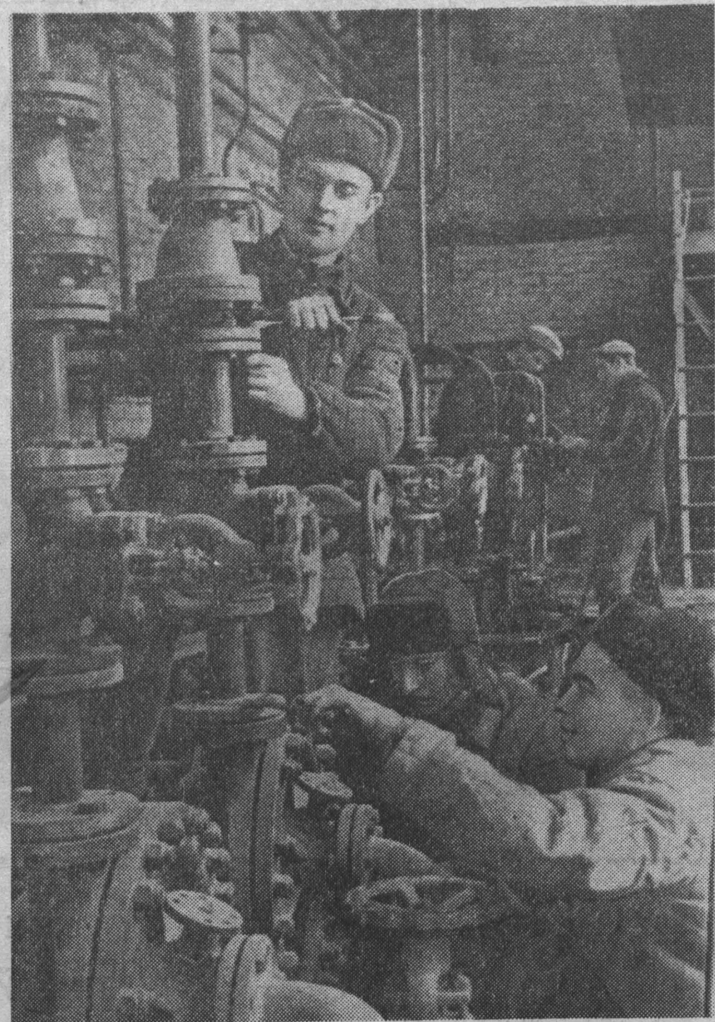
Замечательно трудятся в производственной бригаде Фелдосова, награжденной орденом Ленина. Многие десятки километров трубопроводов смонтированы коллективом на комплексе карболита. Сейчас члены бригады готовят к сдаче насосное отделение цеха моноблочных смол на Кемеровском химкомбинате.
