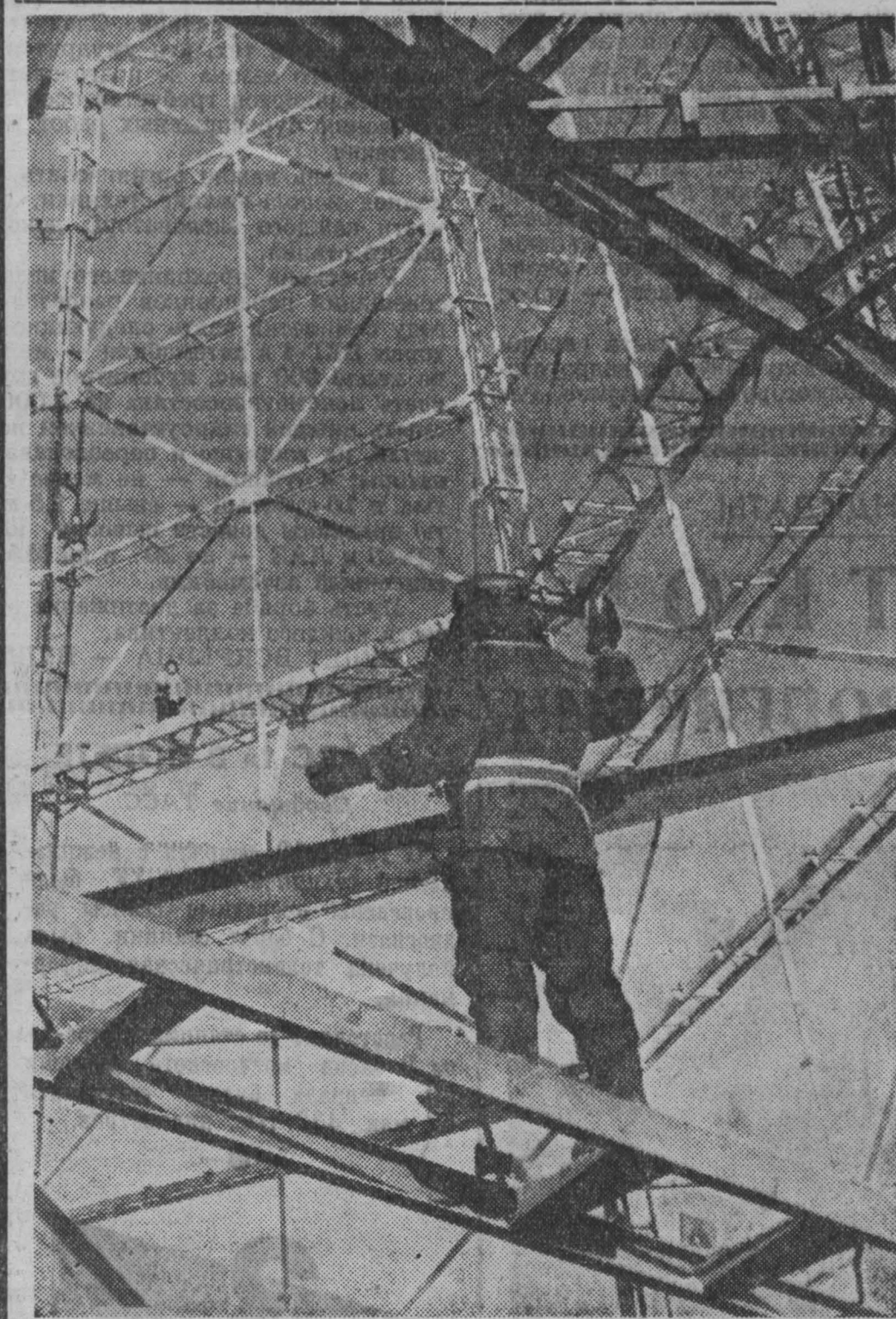
На Кемеровском химкомбинате сооружается комплекс производства моносоединений. На снимке: монтаж градирни производства соды. Фото В. Волынского.
