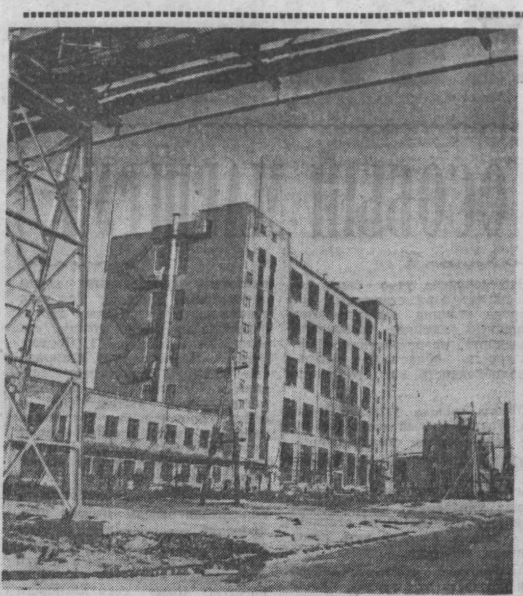
Это комплекс ионообменных смол Ново-Кемеровского химвокнабата, который строили и монтировали слесари под руководством Владимира Турчака. На этом здании будет открыта мемориальная доска рабочей славы с именами ребят из бригады Владимира Турчака.
