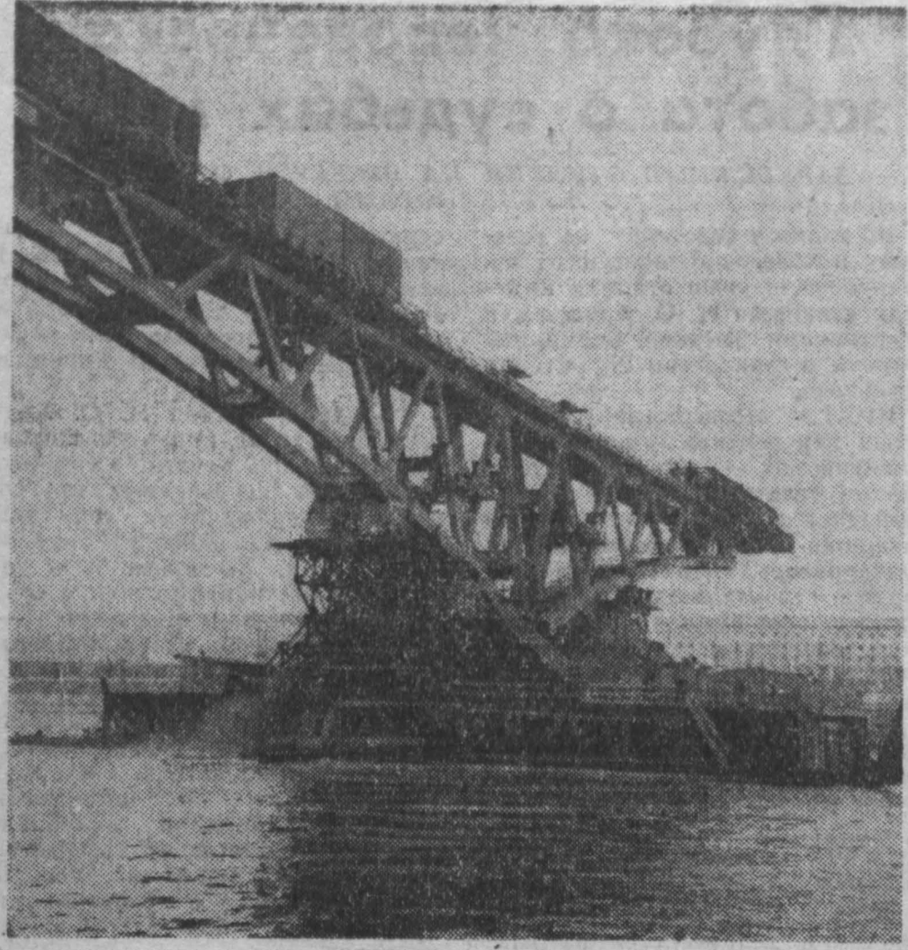
Саратов. Строители крупнейшего в Европе автодорожного моста через Волгу одержали большую победу. Первый предпринятый железобетонный 150-метровый блок весом 2400 тонн, являющийся основой пролетного строения длиной 166 метров, был снят со стелы и на специальных понтонах доставлен к опорам моста. Ведутся работы по установке и закреплению его на опорах. На снимке буксирование блока по Волге к месту установки.
