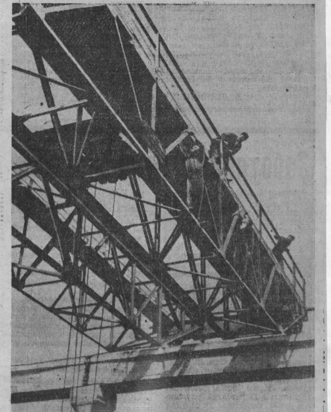
Чехословацкая Социалистическая Республика. Руководствуясь рекомендациями Совета Экономического Взаимопомощи, Румыния поставила ЧССР мощные мостовые краны. Сейчас на заводе «Префа» в Веседа-Луэжиде идет сборка двух таких кранов. Вес каждого 35 тонн. Длина около 25 метров. На снимке: крупная конструкция.
