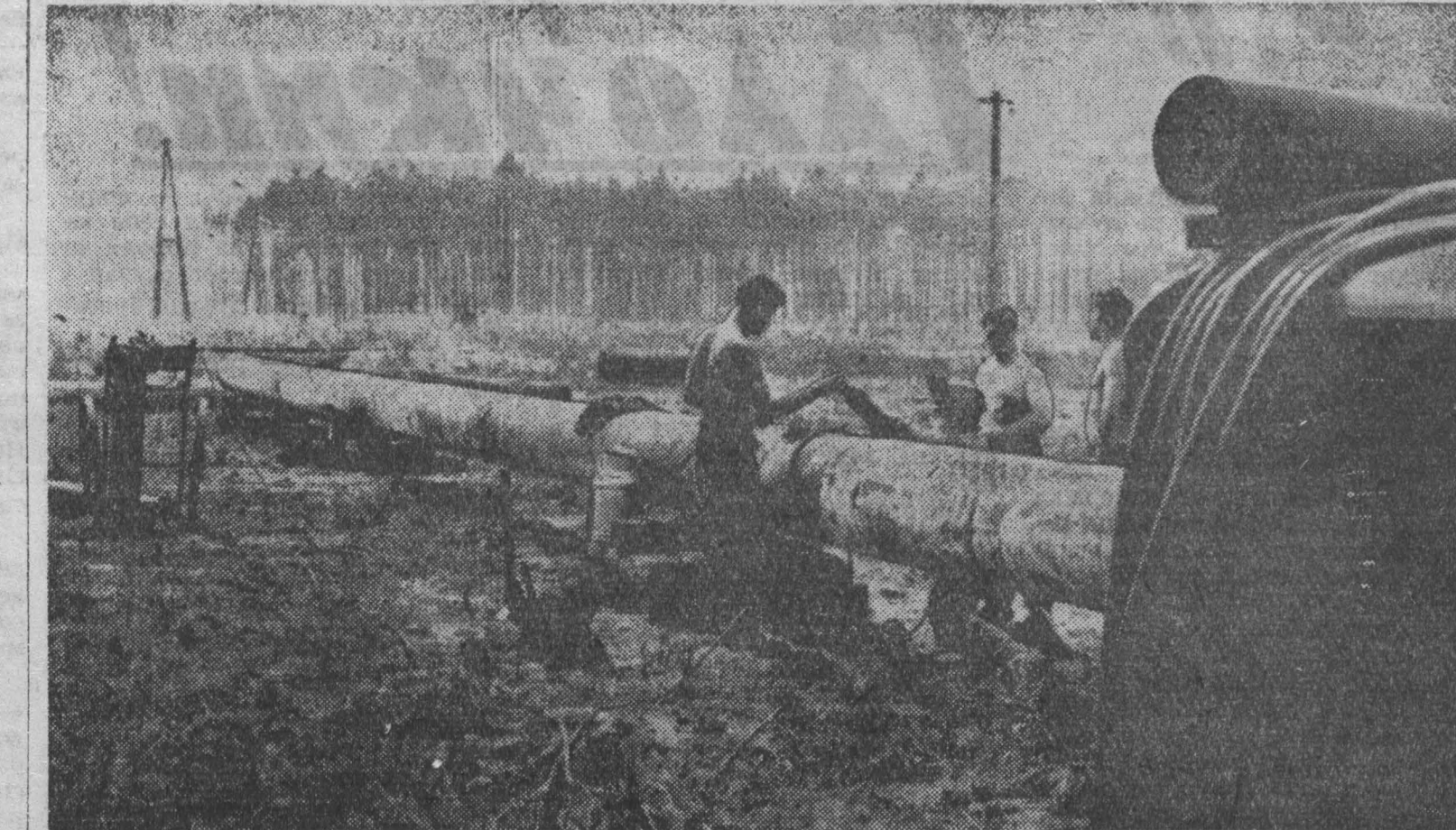
В ноябре по международному нефтепроводу «Дружба» волжская нефть потечет в Польшу и ГДР. Напряжён трудятся строители немецкого участка. Трубопровод, все приемные станции, шлюзовые устройства должны быть готовы здесь к указанному сроку. На снимке: монтажники работы на участке трассы близ Шваца на-Одере (ГДР). Фото АДН—ТАСС.
