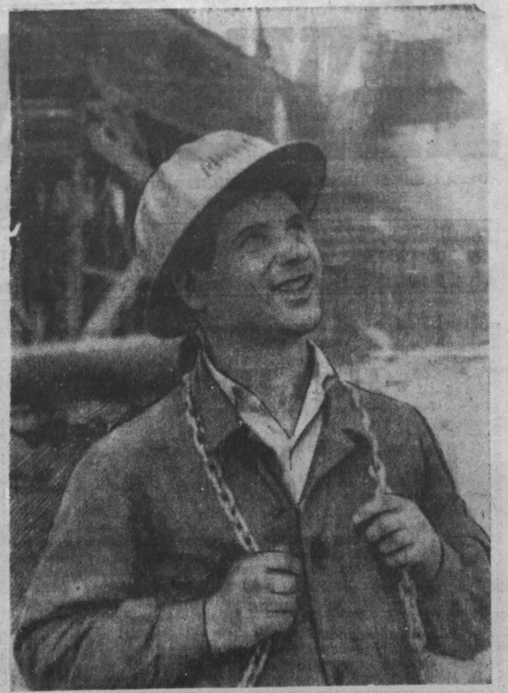
Скоро выдаст первую продукцию первая коковая батарея Запсиб. Строители соревнуются за досрочную сдачу объекта. На днях коллектив Новокузнецкого управления треста «Сибрентвентилиация» рпортовал: «Все объекты технической готовности сдать!».
