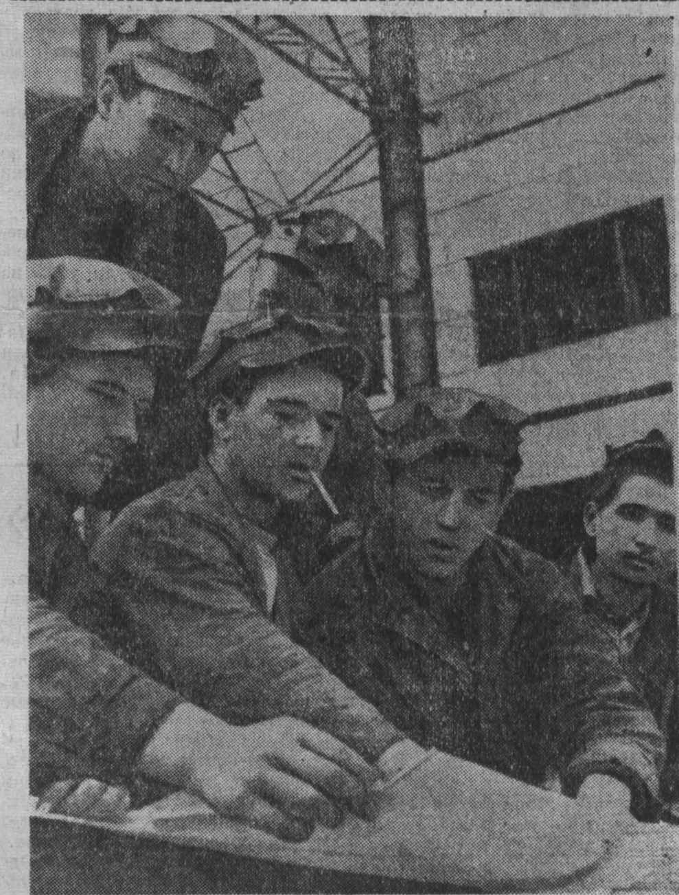
На глазах растет парокотел Беловской ГРЭС. Ни днем, ни ночью не прекращаются здесь работы. В ноябре месяце монтаж котла должен быть закончен.
