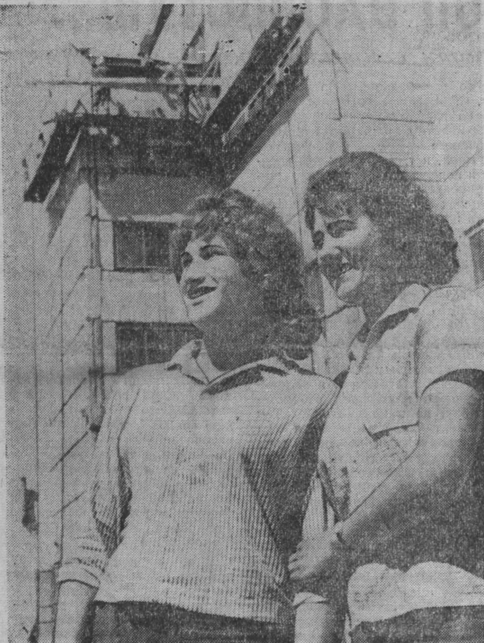
На месяц ехали в командировку из Киева на Запели комсомолки Шура Ткаченко и Валя Борисенко. Им полюбились гигантская стройка, и девушки остались. Теперь они работают на сооружении теплоэлектростанции. И работают отлично.
