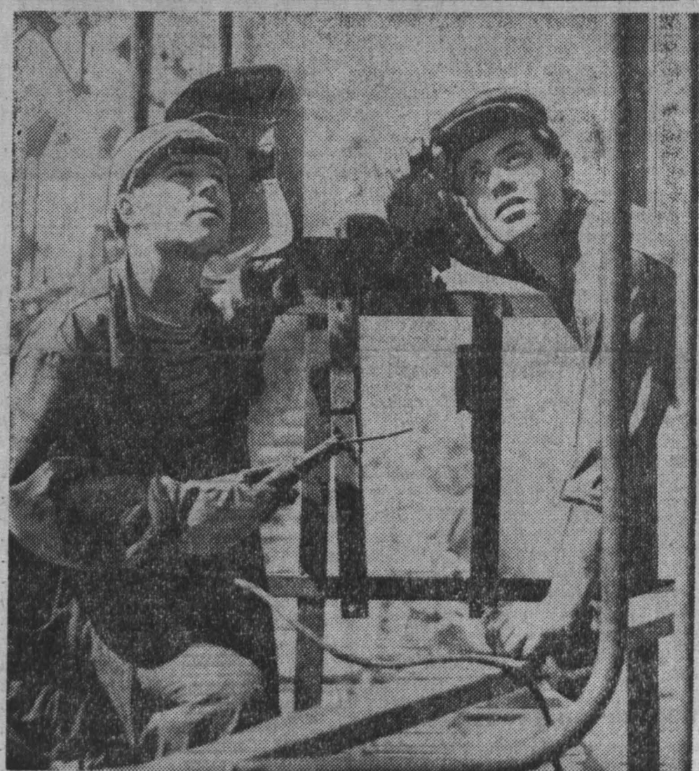
Юрий Шабанов и Виктор Манаенков приехали в Кузбасс из Ленинграда. Им пришлось по душе размах работ и кипучая жизнь индустриального края. Сейчас оба они — монтажники на сооружении первой коковой батареи Западно-Сибирского металлургического завода. Сварка, выполняемая молодыми рабочими, всегда отличалась по качеству.
