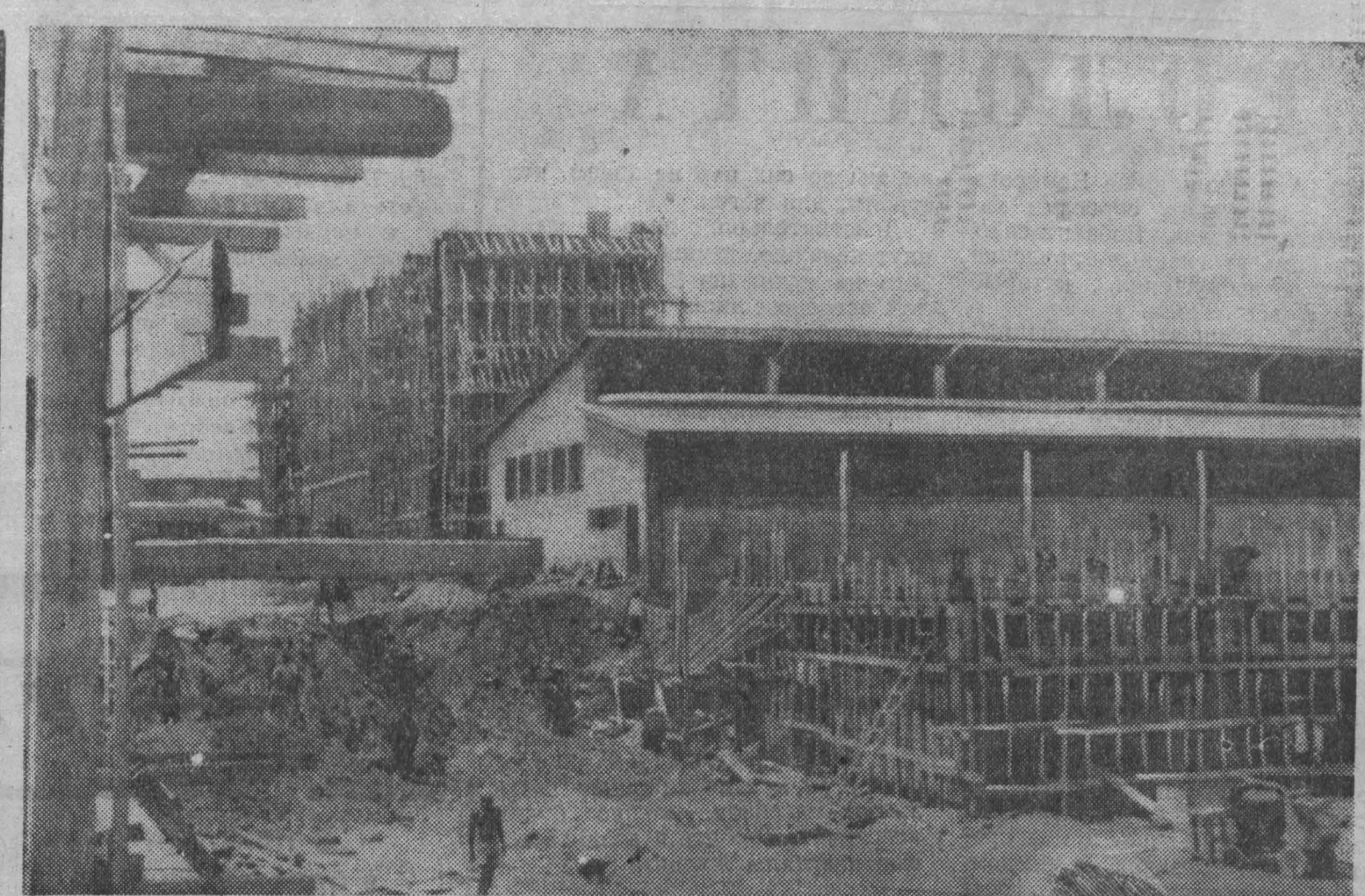
Гана. В городе Tema сооружается большая типография, которая будет выпускать газеты, журналы, брошюры, школьные учебники. Строительство намечено закончить к концу следующего года. На снимке: на строительстве типографии.
