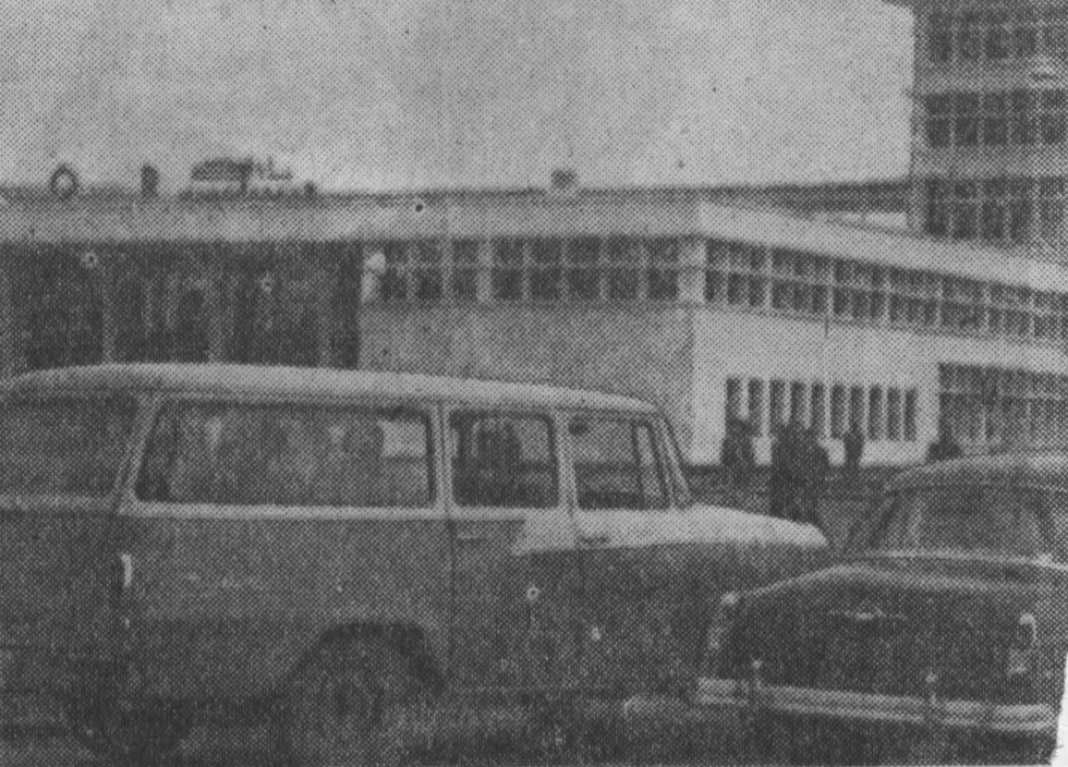
Аэровокзал Кабульского международного аэродрома, построенного при активном участии советских специалистов. В центре — результат совместной дружбы работы НА СНИМКЕ: видный вид аэровокзала.
