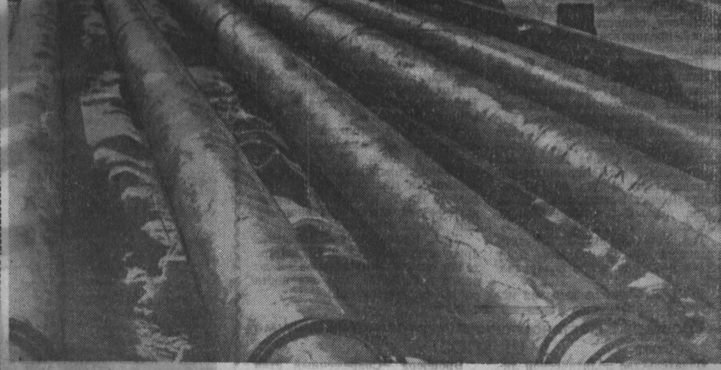
При сжижении угля в топке котлов Томь-Усинской ГРЭС, как и везде, образуются зола и газы. Задержку и очистку их будет вести вода. Для отвода образовавшейся пыли сейчас здесь строят пылеуловитель длиной 24 километра. Пыль будет отведена в спецбассейн. Там вода осветляется и подается вновь на ГРЭС. Таким образом, воздух в районе ГРЭС не будет загрязнен.
